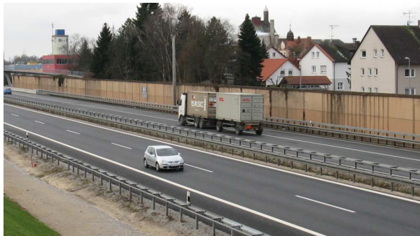
Lärmschutzwand westl. der BAB
