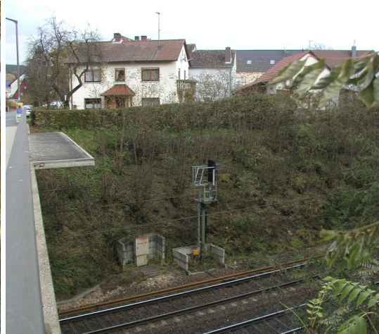
Blick von der Straßenbrücke in Ezelsdorf nach Osten
