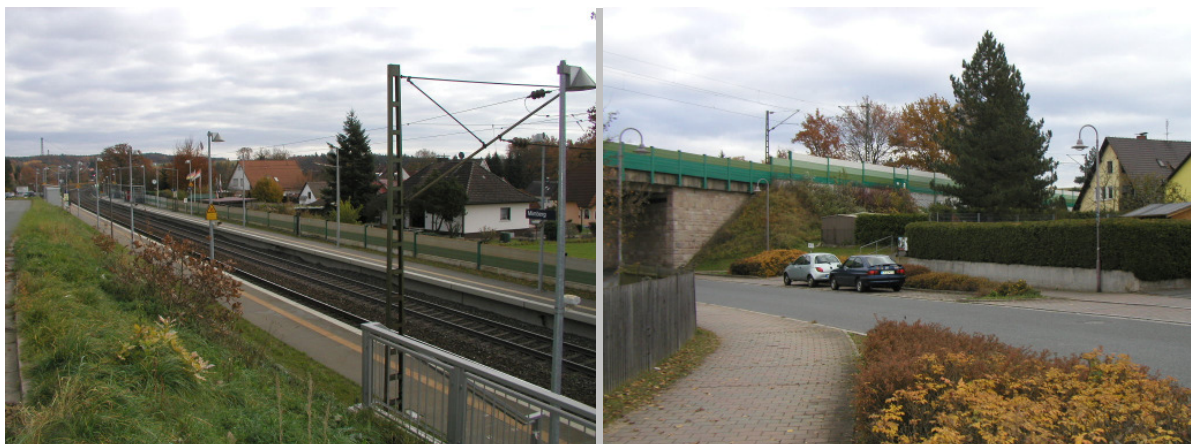
Lärmschutzwand am Haltepunkt von Norden aus gesehen und an der Überführung der Burgthanner Straße
