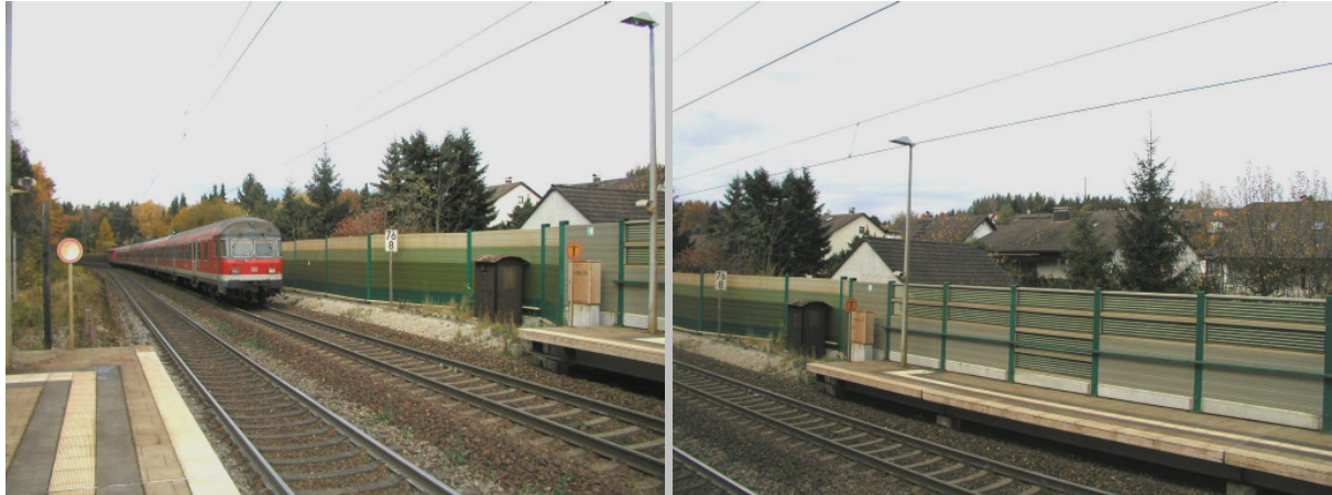
Lärmschutzwand am Bahnhof Oberferrieden
