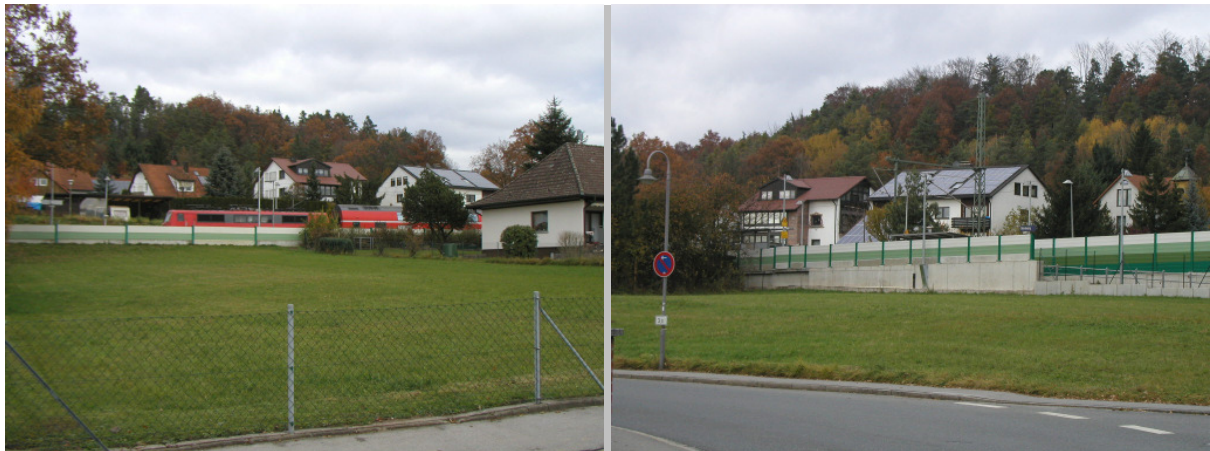
südliche Lärmschutzwand im Bereich des Haltepunktes Mimberg
