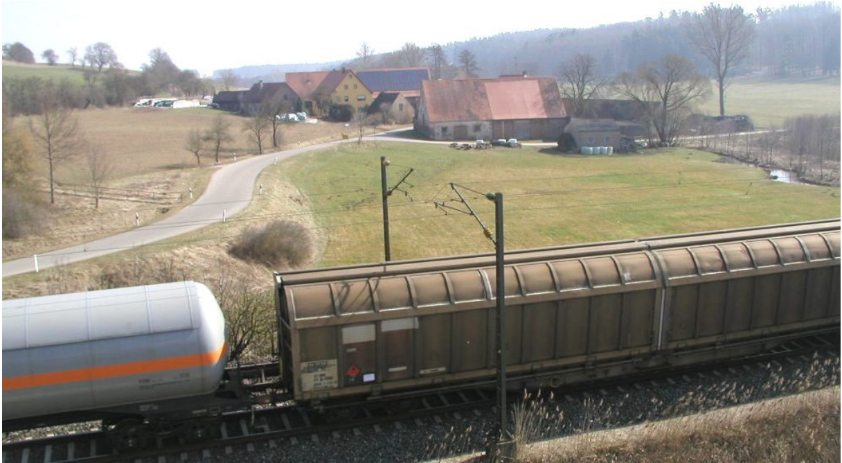
Foto 5: Ortsteil Kellern (östlich der Bahnlinie)
