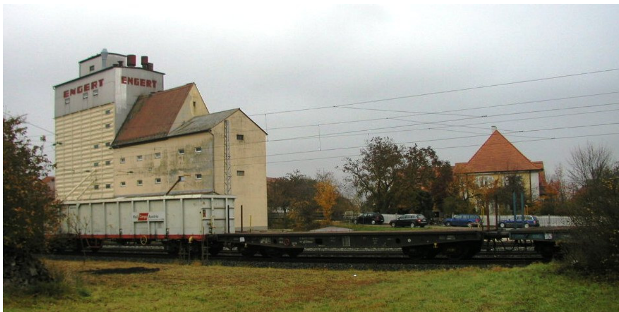
Bild 2: Ortsteil Herrnbrechthheim, Lagergebäude und Wohnhäuser an der Bahnlinie
