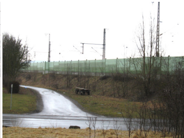
Lärmschutzwand im Bereich des Sportplatzes zur Abschirmung des hier südlich (im Bild links) liegenden Wohngebietes.
