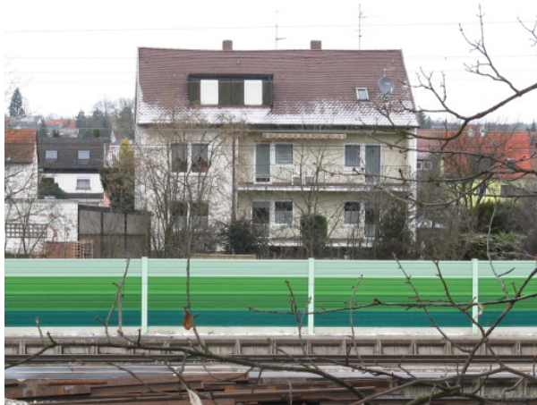
Lärmschutzwand im Bereich des Bahnhofs Siegelsdorf
