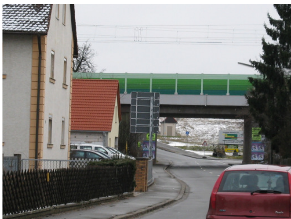
Lärmschutzwand in Siegelsdorf
