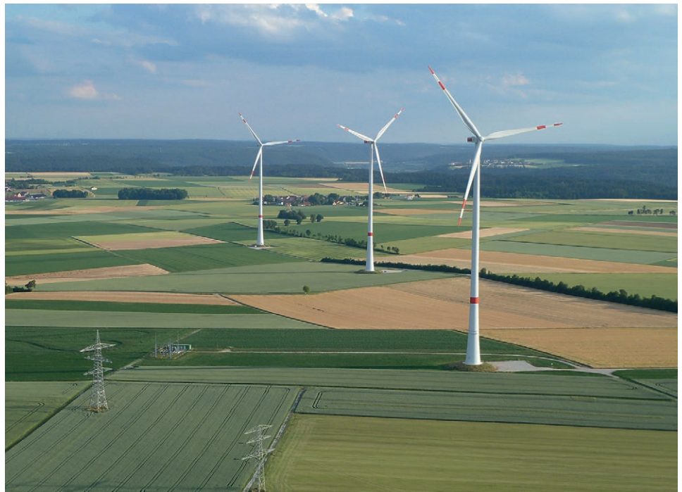
Bei den WEA Berching 5 bis 7 handelt es sich um Anlagen des Typs Senvion 3.2M114.
