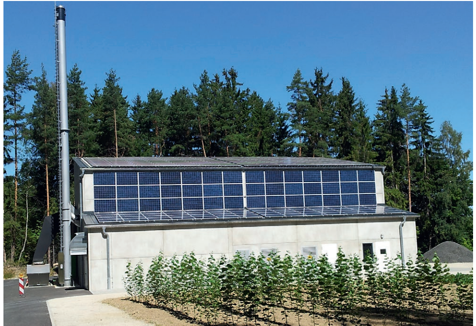
Das Heizkraftwerk von Bad Alexandersbad
