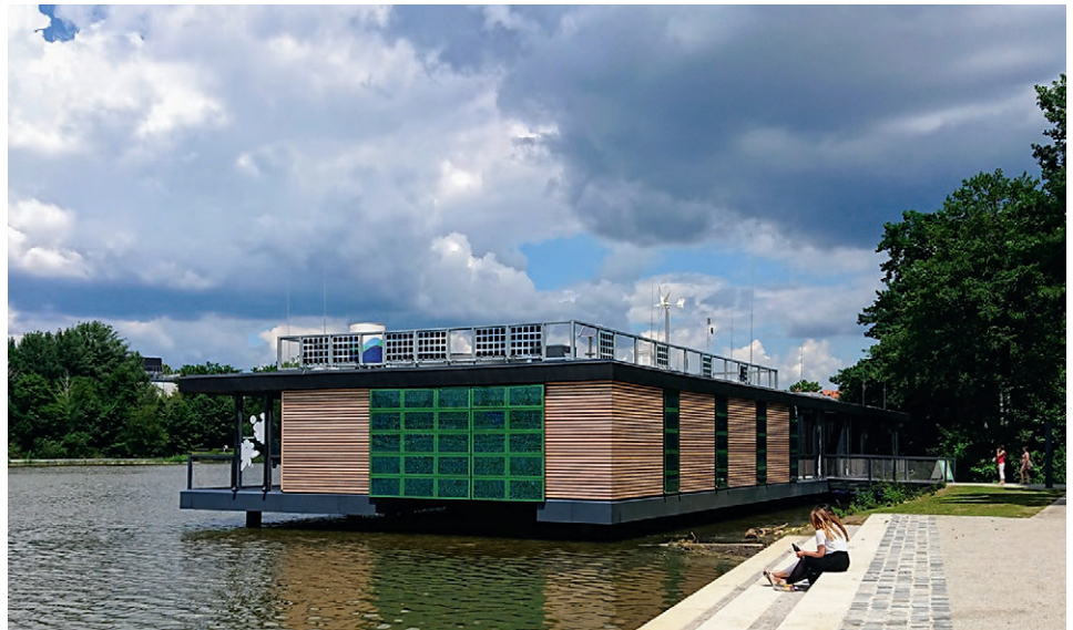
Südansicht der Energie- und Umweltstation
