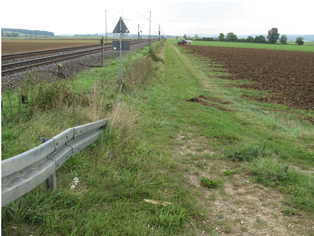
BÜ 13,7: Richtung Anwandweg Quadrant II
