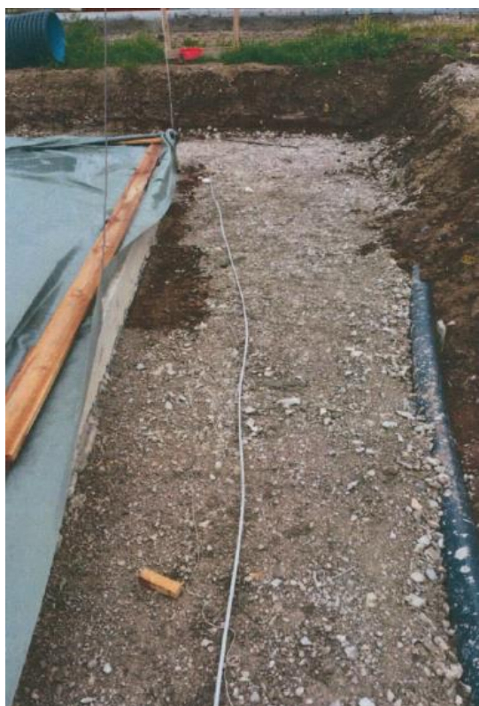
Abbildung 7 UW Finkenbrunn Erdungseinrichtung
