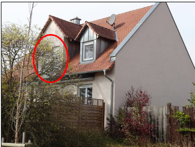
Abbildung 7: Wohnhaus "Markgrafenstraße 28" (hier: IO 2)
