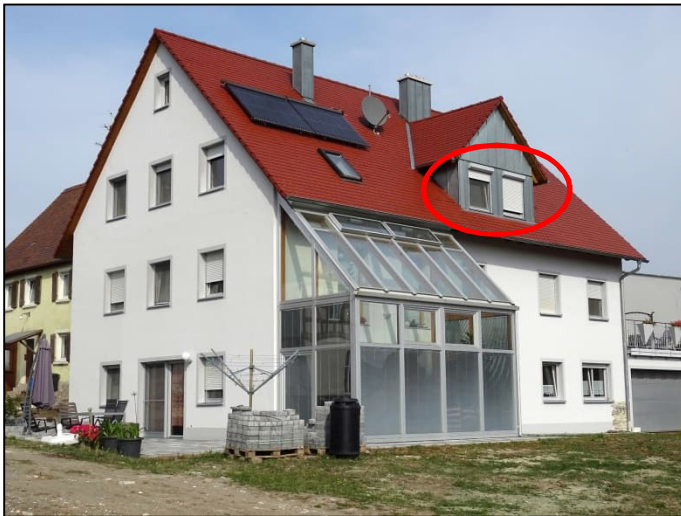
Abbildung 8: Wohnhaus "Markgrafenstraße 32a" (hier: IO 3)
