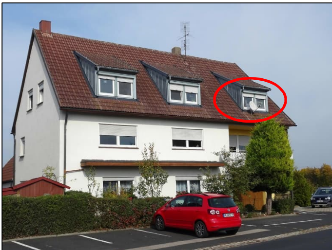
Abbildung 9: Wohnhaus "Markgrafenstraße 27" (hier: IO 4)
