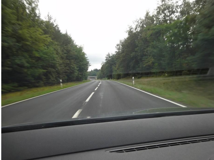
ABBILDUNG 5: FOTOAUFNAHME KUPPE IM STRAßENVERLAUF VOR AS
