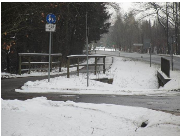
ABBILDUNG 12: FOTOAUFNAHME VORHANDENER GEH- UND RADWEG AM BAUENDE (SÜDLICH DER A 6)
